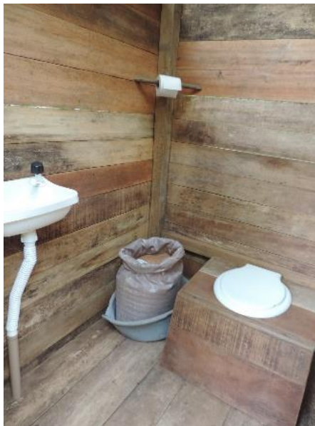
Figura 6 - Banheiro seco construído
