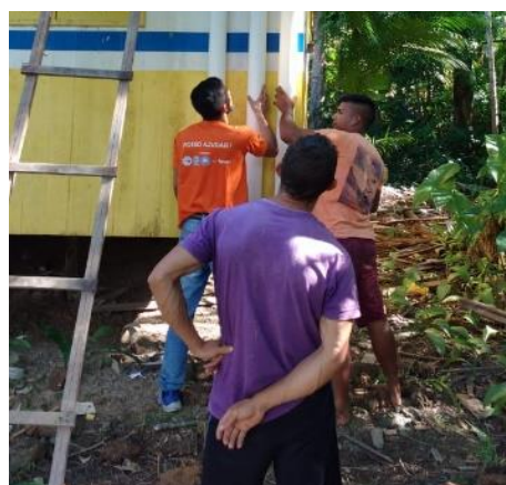
Figura 4 - Comunitários e equipe técnica atuando em conjunto na implantação das unidades de captação de água.
