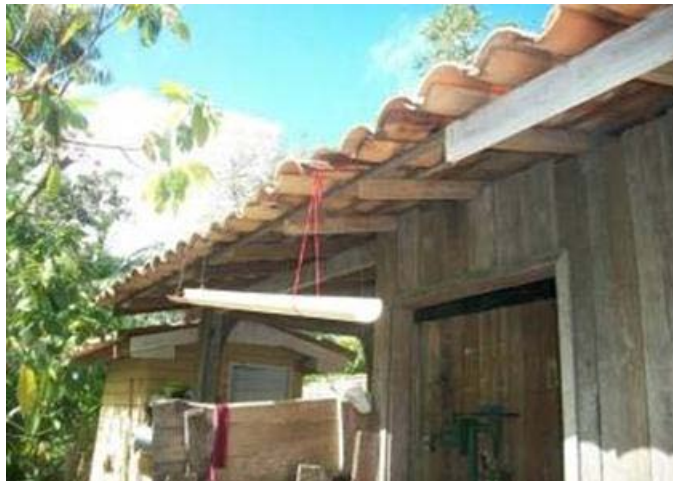
Figura 10 - Sistema de captação da água da chuva improvisado por moradores.
