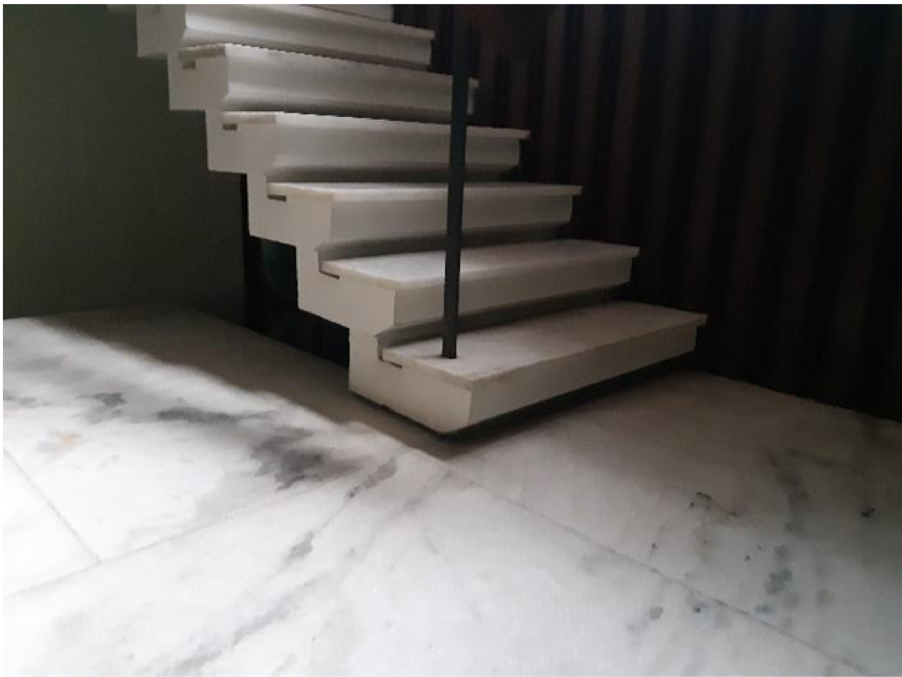
Figura 7: Acesso à garagem
