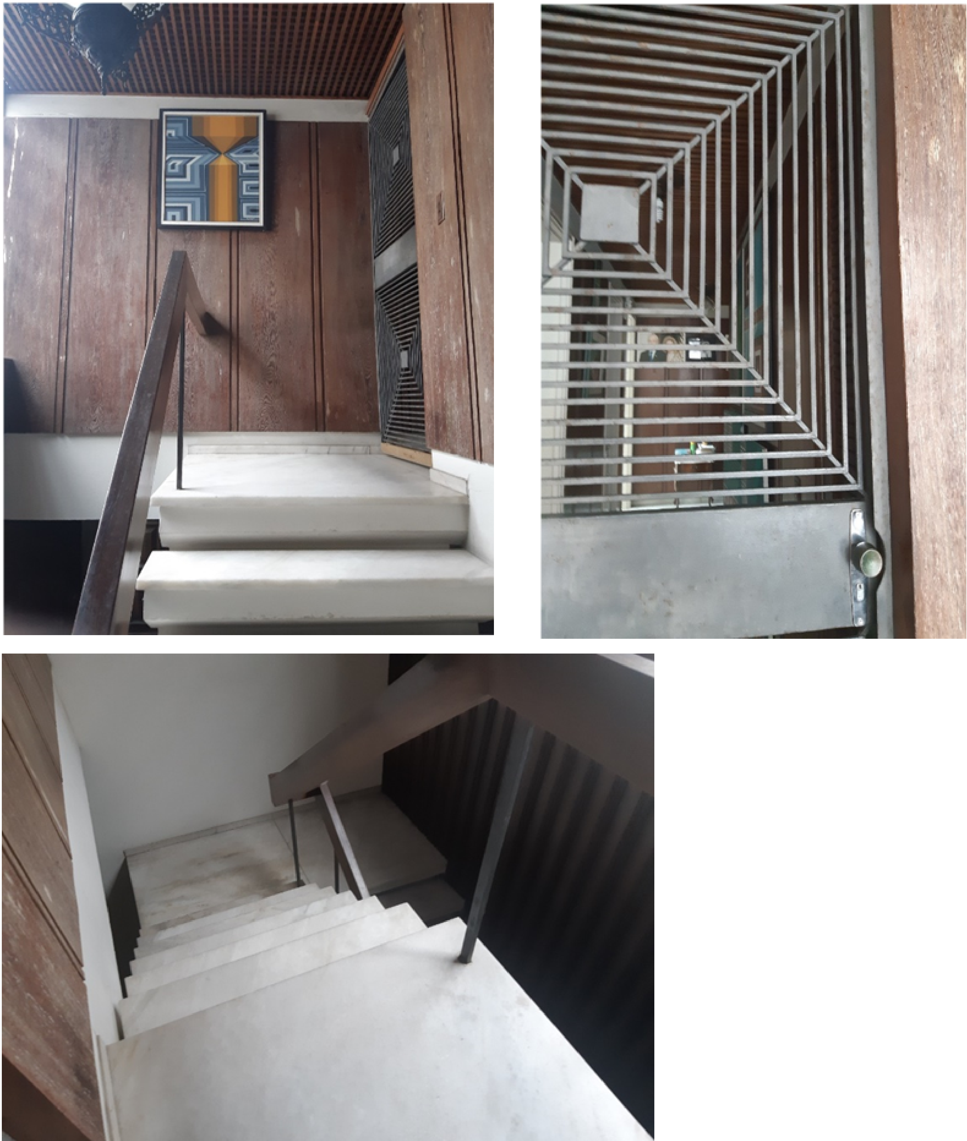
Figura 6: Acesso ao 2º pavimento e porta de segurança
