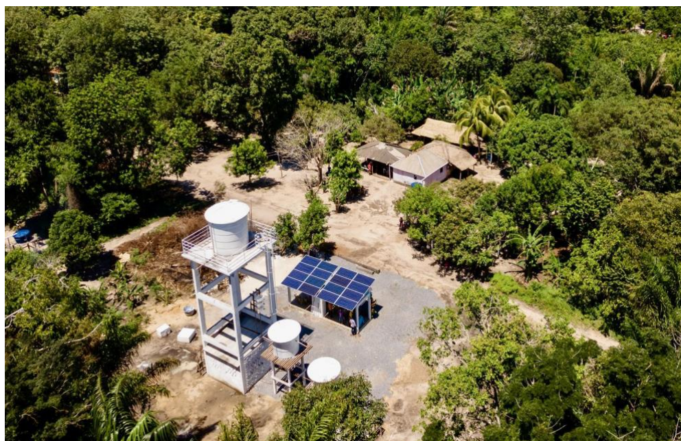
Figura 1 - Sistema de Abastecimento de Água da comunidade de Mangal, na Resex Tapajós/Arapiuns.
