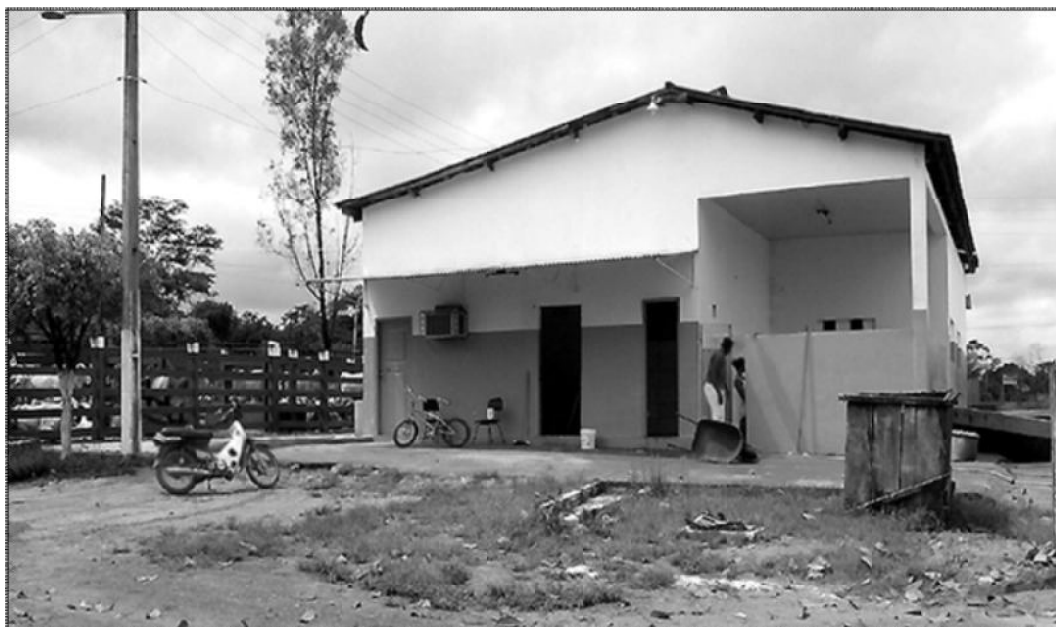
Figura 12 – Matadouro municipal de Rondon do Pará.
