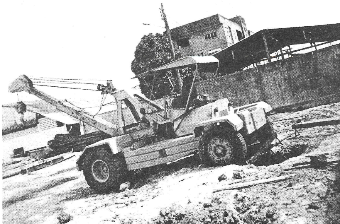
Figura 04 – Características do sistema de reação, e detalhe do afundamento do pneu do guindaste
