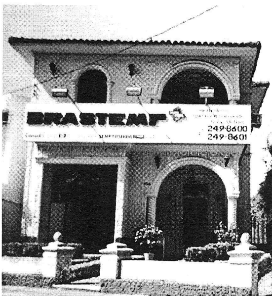
Figura 1: típica residência com inspirações neocoloniais, décadas de 30/40.
